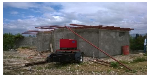
Les sanitaires en construction
