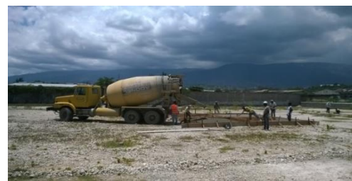
Coulage de la dalle de l'abri d'accueil
