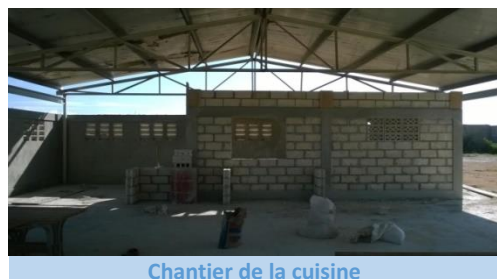
Chantier de la cuisine
